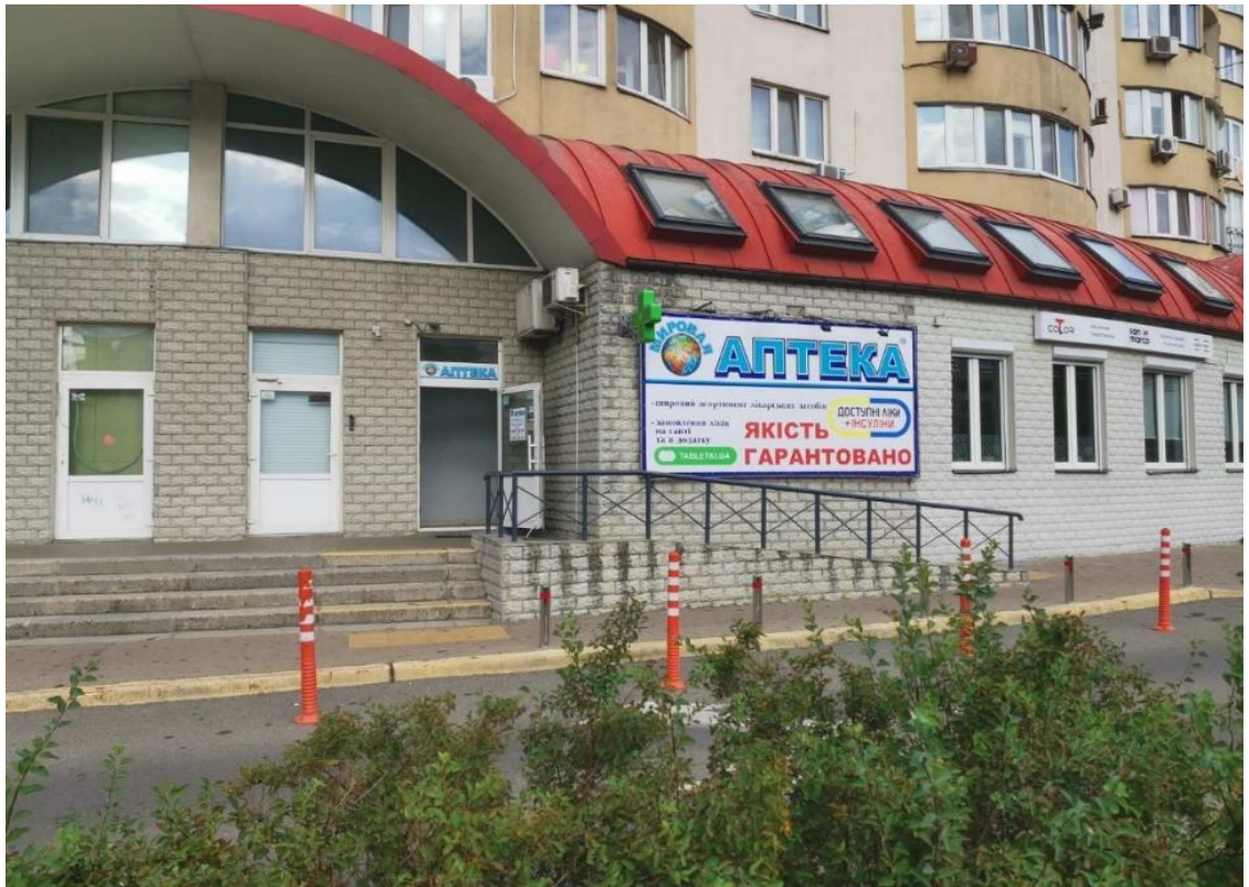
Фотокопія 5. Зовнішня конструкція будівлі Аптечного закладу Товариства на 09.08.2024
